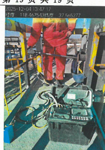
DA011 二胺北厂区选料包 装废气净化装置排气筒
