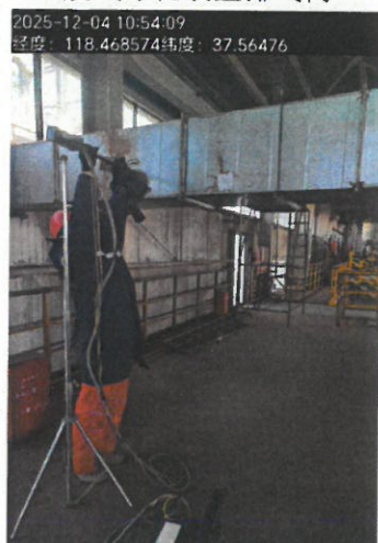
DA012 二胺北厂区筛分包 装废气净化装置排气筒
